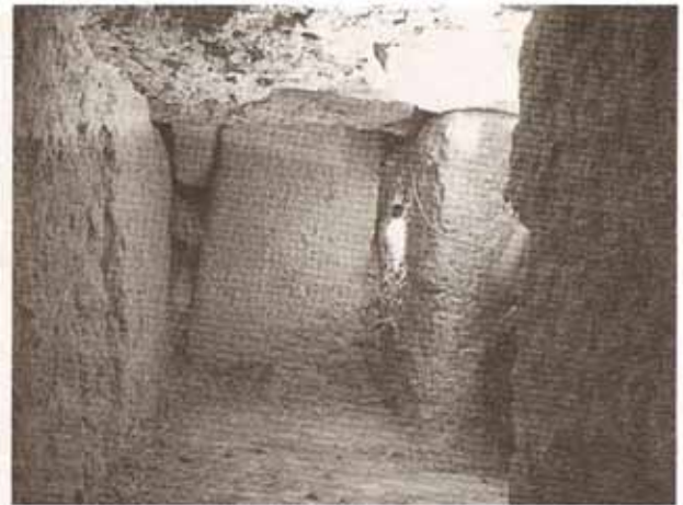
شکل ۵. بخش داخلی آبراهه در زیر گوشه جنوب شرقی خزانه. پس از مسدود شدن مسیر شمالی-جنوبی به طرف خزانه، مسیر آبراهه به طرف شرق و در امتداد بخش شرقی تخت تغییر داده شد.
